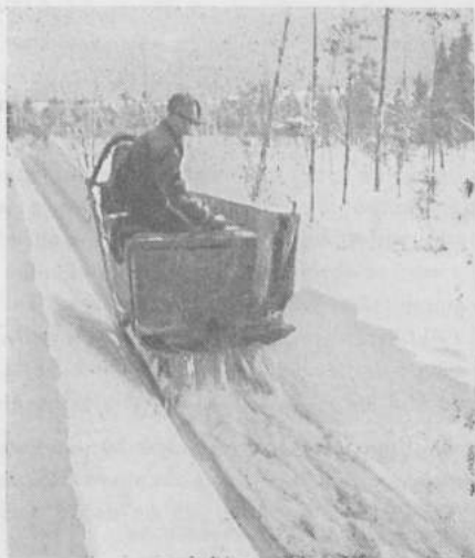
Kuva 37. — Kevytrakenteinen, 30 cm lumensyövytyteen asti hoito-auraukseen soveltuva raidehöylä. — Valok. S. D. A.
