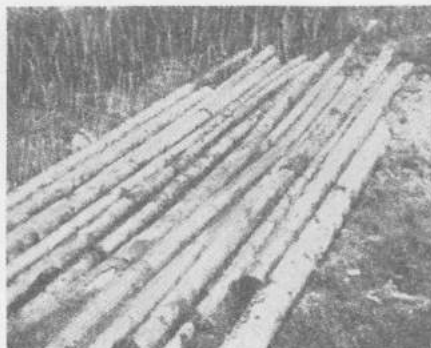
Kuva 11. — Höylättävän jäätien telapuu pehmeillä soilla on asetettava pituussuuntaan. — Valok. S. D. A.
