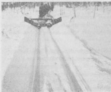
Kuva 25. — Varsitien aukaaisuauraus käynnissä vanhanmallisella aura-höyläyhdistelmällä.
