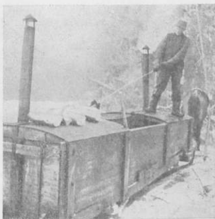
Kuva 31. — Lämminvesilaatikko, jossa on 2 kaminää veden kuumentamiseksi. Sen käyttö säästää sekä aikaa että vettä. — Valok. S.D.A.
