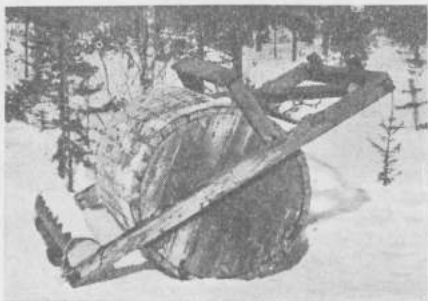
Kuva 27. — Yksinkertainen, puusta rakennettu, hiekalla täytettävä lumijyrä.
