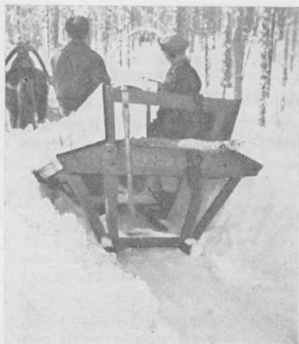
Kuva 46. — Vaikeissa olosuhteissa voidaan kavioura avata erikoisella työnnettävällä kavioura-auralla. — Valok. S.D.A.
