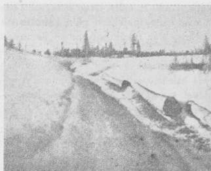
Kuva 35. — Ohjepuilla vahvistettu ajoradan reuna. Puut ovat oikealla korkeudella ja lumesta puhtaat. — Valok. S. D. A.
