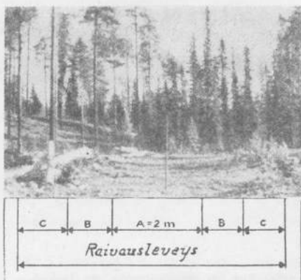
Kuva 5. — Maaperustainen raivaus. A. Hyvin tasattu ajorata. B. Auransiipiä varten karkeasti tasattu alue. C. Poistettavaa lunta varten raivattu, mutta tasaamaton alue. — Valok. S. D. A. ←
