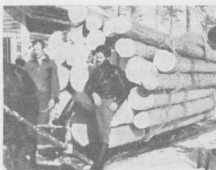
Kuva 4. — Korkeimman luokan jäätiellä on 396 j 3 :n ja n. 12 tn painoisella suurkuormalla ajo mahdollista.
