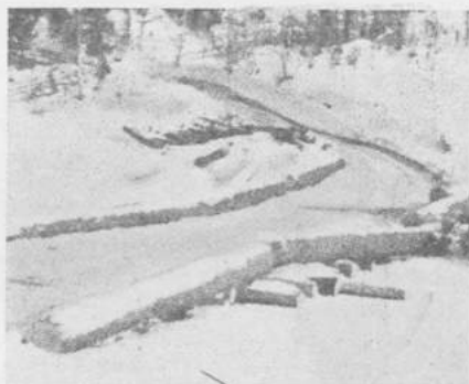
Kuva 12. — Milloin veden korkeus vaihtelee, on telotus ulotettava kovan maan rajaan asti. — Valok. S. D. A.
