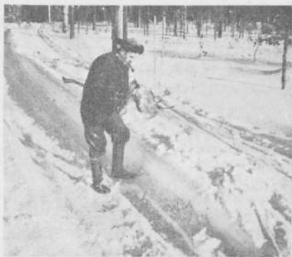
Kuva 39. — Tiemiehen on olettava raiteissa olevat mutkat ja tasattava heitteet.
