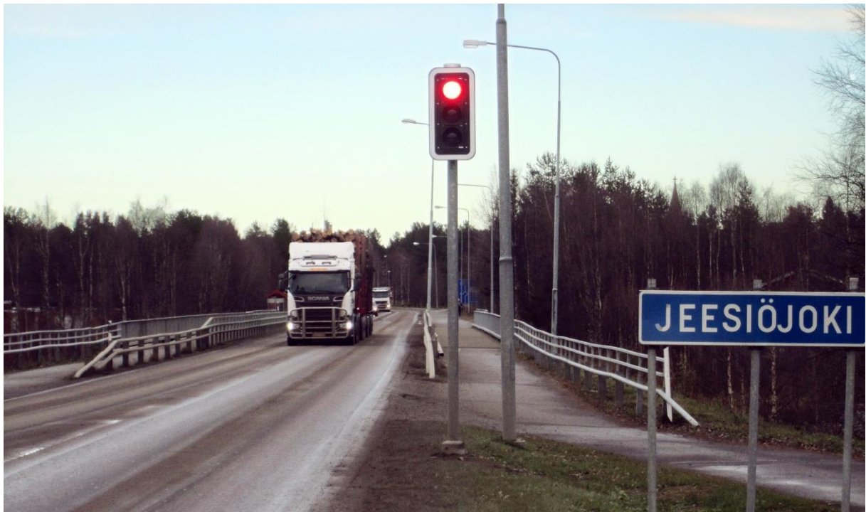
Kuva 41. Jeesiöjoen sillan liikennevalot estivät muun liikennöinnin sillalla saman aikaan HCT-yhdistelmän kanssa (Kuva: Ari Siekkinen). Liikennevalot ovat nyt samassa käytössä Kitisenjoen sillalla.
