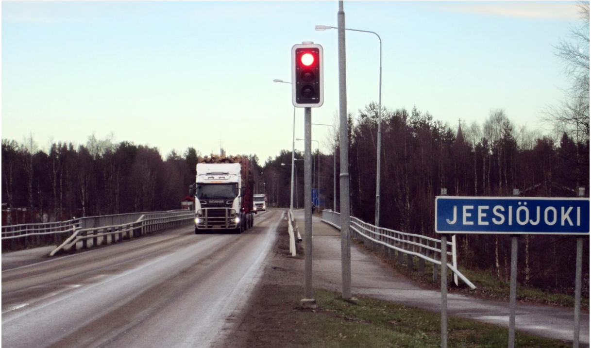
Kuva 45. Jeesiöjoen sillan liikennevalot estivät muun liikennöinnin sillalla saman aikaan HCT-yhdistelmän kanssa (Kuva: Ari Siekkinen). Liikennevalot ovat nyt samassa käytössä Kitisenjoen sillalla.
