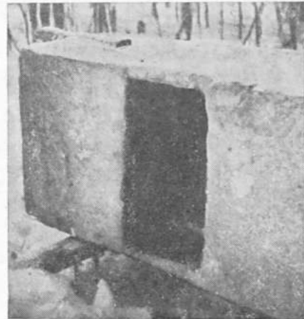
Kuva 31. — Kylmävesilaatikoiden yhtenä pahana vikana on veden jäätyminen seiniin, pohjaan ja kanteen. — Valok. K. P.
