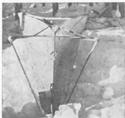
Kuva 1. — Työnnettävä »B-N kavioura-aura». Laitteen edessä näkyvät hangenleikkausveitset.
