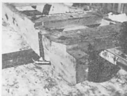
Kuva 6. — Vaakasuorat kimpiterät, joissa terien suut on taivutettu alaspäin kimmelle. Terät on kiinnitetty höylän polijarautojen jatkoksi, ja leikkaussyvyyden säätö tapahtuu terien edessä olevien »suksien» avulla. (Malli IV).
