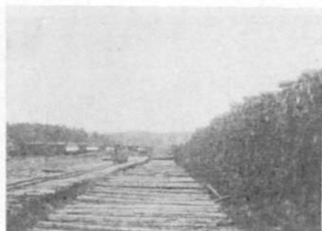
Kuva 28. Varastoalue. Oikealla valmis pino, sen ja varastoraiteen välissä syntyneessä uutta pinna. - Fig. 28. Storage area. On the right a completed pile, between it and the storage track the beginnings of a new pile.
