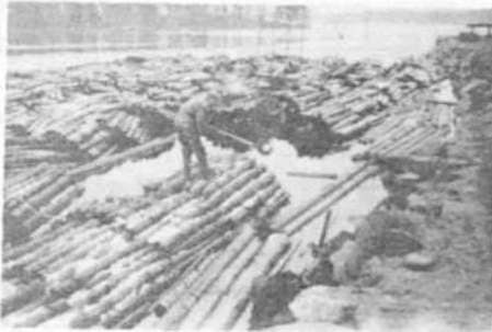
Kuva 2. Järvimies vetämässä nosturin koukkuja uittohaan avulla seuraavana nostettavan nipun luo. Valok. Metsäteho. - Fig. 2. The "lakeman" using a boat-hook to draw the crane hook to the next bundle to be lifted. Photograph Metsäteho.
