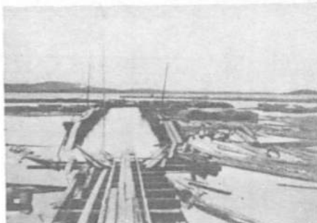
Kuva 7. Rullavaunujen kuormauspaikka. Oikealla näkyy pengeri, joka suojaa tuulilta. Huom. pitkän salon päässä oleva merkinantolaitte. Valok. Metsäteho. - Fig. 7. The trolley loading site. On the right a bank which provides shelter against the wind. Note the signalling device at the top of the long pole. Photograph Metsäteho.
