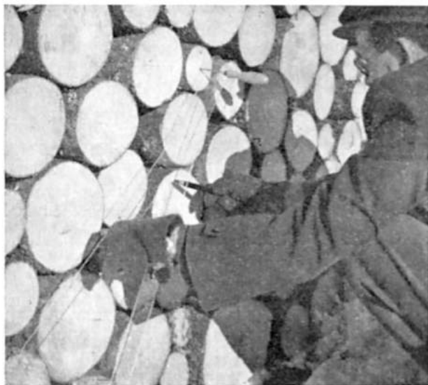
Kuva 3. Pölkkyt joiden läpimitta on suurempi kuin kiilan leveys, merkitään.
