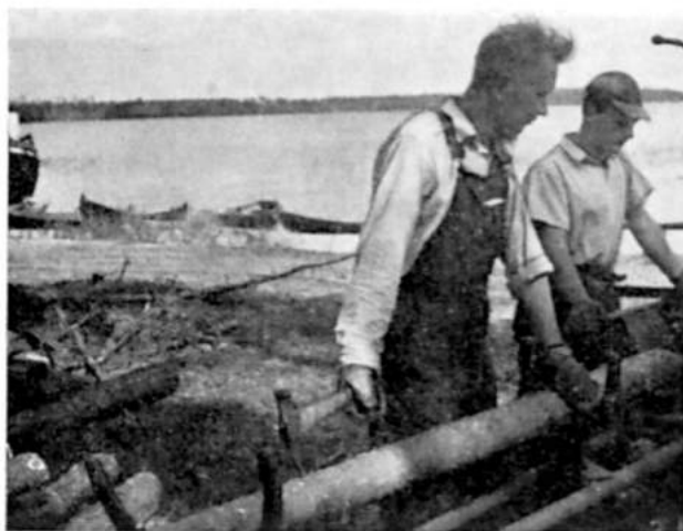
Kuva 5. Taloudellisuuden parantamiseksi konekuorintaan pyritään yhdistämään muitakin työvaiheita. Tässä tavarankatkonta on tapahtunut syöttäjän toimesta ennen pölkkyjen siirtelyä koneelle. Syöttäjän kädessä yhdistetty merkkauk-vasara-pokara.
