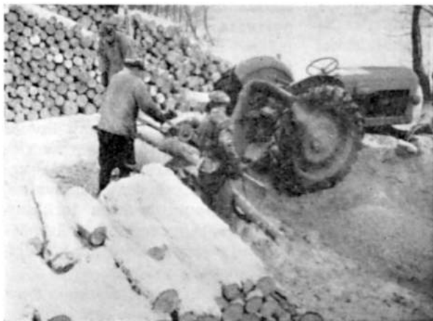
Kuva 3. 2-metrinen havupölkkyjen talvi-kuorintaa traktori-käyttöisellä Veikko II koneella. Työryhmä 3 miestä. Syöttäjä heittää pölkylt suoraan syöttöpyörille.
