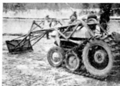
Kuva 8. Puutavara-kuormien purkamiseen käytetty, pyörätraktoriin asennettu työntöpuskuri.
