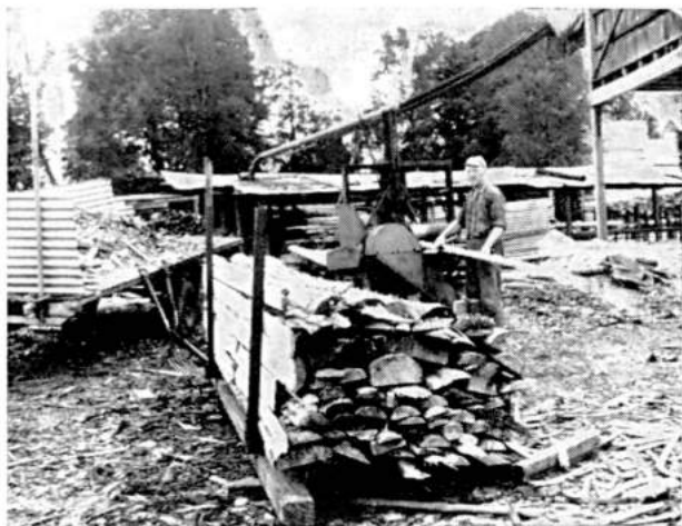
Kuva 2. AIP 300 rimakuorimakoneella kuoritut pintalaudat ja järeämmät rimat niputetaan Ruotsin piensahoilla yksinkertaisissa puukehikoissa.
