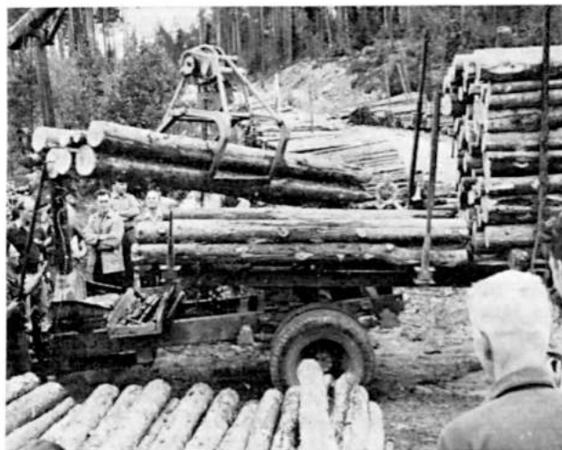
Kuva 4. Takimaiset pankot kuormineen on siirretty perävaunun takaosaan, jonka jälkeen kuormataan etumaisille pankoille tuleva kuorma.
