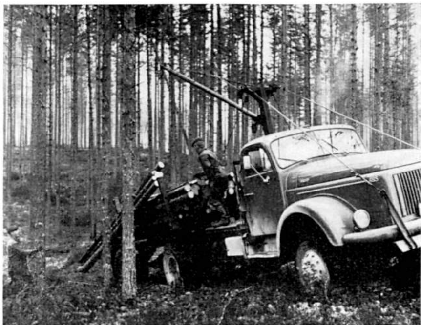
Kuva 10. Palstalta ajoa nelipyörävetoisella kuorma-autolla. Tässä kuormaus tapahtuu Joutsa-nosturilla ns. vaijeritaakkoina.
