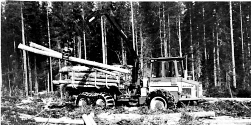
Kuva 1. Ponsse S15 -kuormatraktori. Valok. Metsäteho
