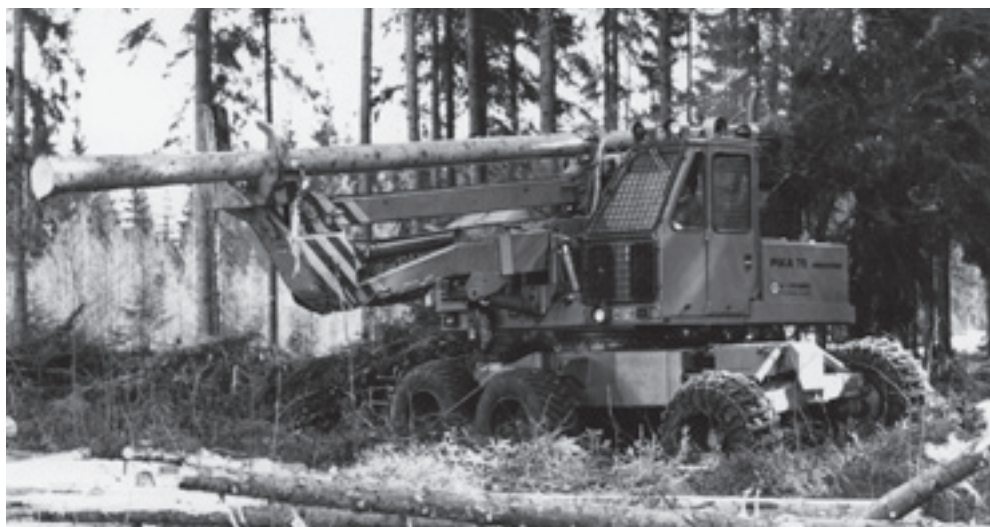
Puun kaadon yhdistäminen karsinta-katkontakoneeseen oli ratkaiseva kehitysaskel. Pika 75 oli ensimmäinen suomalainen kaato-karsinta-katkontakone (harvesteri). Sakari Pinomäki rakensi koneen vuonna 1971. Tämä kuva on vuodelta 1976.
