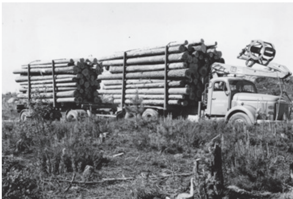
Puutavara-autokalusto alkoi kehittyä ripeästi 1960-luvun lopulla. Kuvassa kuljetusyrittäjä O. Hämäläisen hydraulisella Hiab-nosturilla ja täyperävaunulla varustettu 3-akselinen Volvo mäntylastissa. Luumäki 1969.
