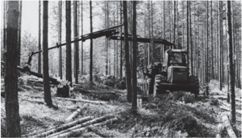
Pitkäloukotteilla kuormaimella varustetusta kuormatraktorista tuli lähikuljetuksen yleisratkaisu 1970-luvun aikana. Kuvassa Valmet 882 K, jossa on Fiskars-kuormain ajamassa metsurityönä hakattua puutavaraa. Karkkila 1979.
