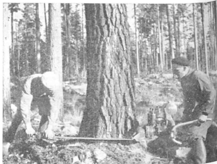
Fig. 5. Fällning med motorsåg intill mark.
