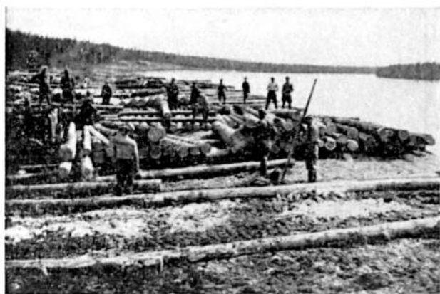
Kuva 4. — International TD-9 työntää kaksi välitelatonta kasan osaa (yhteensä 65 tukkia) yhdellä työllä veteen. Valok. Aimo Rautela, Muonio, Muonionjoki, 1949.
