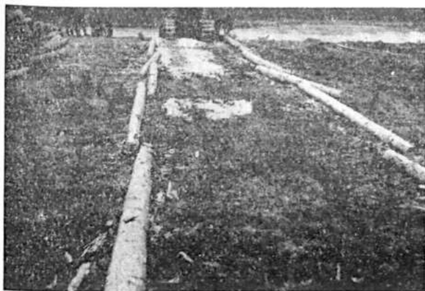
Kuva 6. — Alustelat pysyvät hyvin aseteltuina paikoillaan työnnekin aikana. Huom. Telojen limittäinen asettelu (vasemmalla toisena oleva tela ollut kasan alla jäädessä väärään asentoon). Valok. Aimo Rautela, Muonio, Muonionjoki, 1949.
