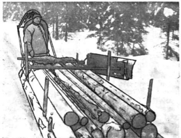
Kuva 6. — Arnkilän »vallinleikkaajan» käyttöperiaate. Laite kiinnitetään sopivalle korkeudelle kuorman päälle. Työntölevyn etäisyys ja kaltevuuskulma ovat säädettävissä.
