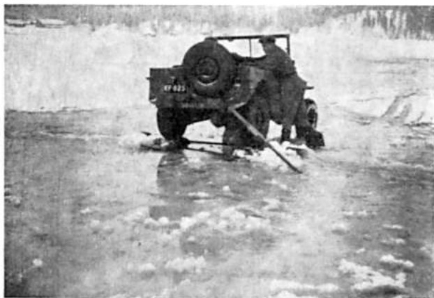
Kuva 5. Kahdella pumpulla vesitys on kahden miehen työtä. Pumppejen on oltava akselin mitan päässä toisistaan ja ehdottomasti vaakatasossa. Valok. Metsäteho. Fig. 5. — Watering with two pumps is a job for two men. The pumps must be a shaft length's distance from one another, and absolutely on the same level.
