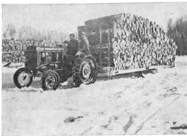
Kuva 1. Puutavaran kuljetus käynnissä talvitietä pitkin n. 2 tn painoisella pyörätraktorilla. Ns. puolireessä olevan kuorman suuruus n. 30 p-m 3 (n. 16 000 kg). — Valok. Metsäteho
