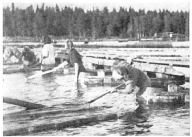
Kuva 2. Huonosti näkyvät päämerkit ovat pöntöissä seisovien erottelijoiden jatkuvana kiusana ja erottelun jarruna. Pölkyn pää on keksillä nostettava ylös vedestä merkin toteamiseksi. Valok. Metsäteho. — Fig. 2. A poorly visible mark makes it necessary for the sorter to lift the end of the log out of the water. Photo by Metsäteho.
