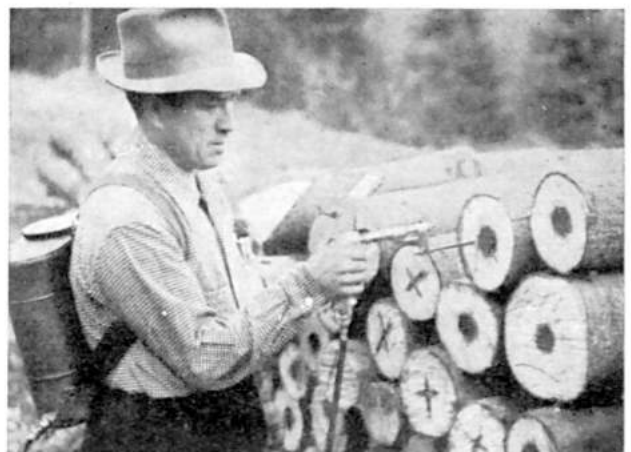
Kuva 6. Amerikassa kehitetyllä Pohle-ruiskulla saadaan halutunlaisia värimerkkejä käyttämällä erilaisia rajoittajia. Pistoolin laukaisijan kärki painetaan pölkyn päätä vasten. Valok. Northeast Pulpwood Research Center. — Fig. 6. An American Pohle Spray Gun. Photo by Northeast Pulpwood Research Center.
