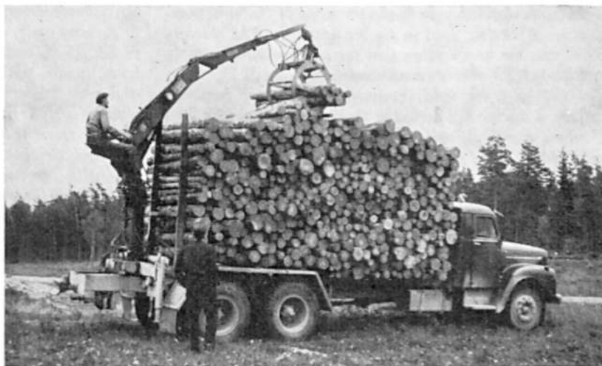
Kuva 5. Ruotsalainen hydraulisesti toimiva Hiab pinotavaran kuormaja, jolla kuljettaja voi kuormata yksinään. Se voidaan sijoittaa joko autoon tai varsinaiseen perävaunuun. — Valok. SDA.
