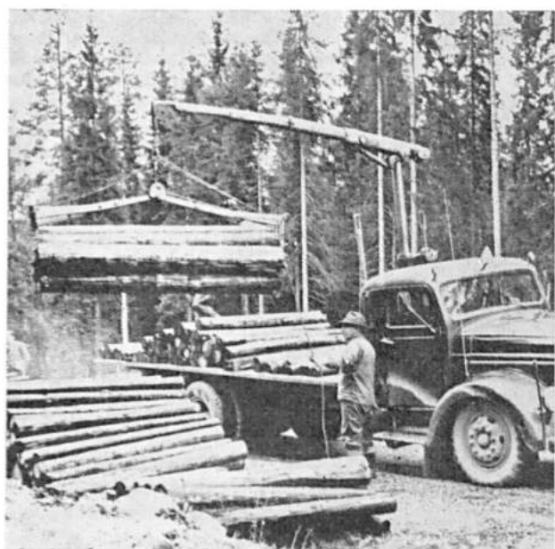
Kuva 4. Ruotsalainen Långban kahmain, joka on asennettu hydrauliseen puominosturiin. Sitä voidaan käyttää myös mekaanisessa puominosturissa. Se soveltuu 2...3 m pituisen tavaran kuormaamiseen. Kuormaamisessa lienee sopivin kahden miehen työryhmä.
