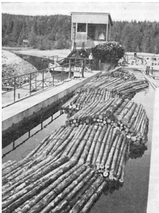
Kuva 8. Puntarikosken nippunosturi paperipuunippujen täyttämän syöttökanavan puolelta nähtynä. Fig. 8. The bundle lift at Puntarikoski seen from the feeding channel full of pulpwood bundles.
