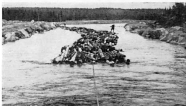
Kuva 1. Nippu-uitto asettaa sangen korkeat vaatimukset uittoväylän laadulle. Syvyyden tulee olla vähintään 2 m. Yhden nippusäikeen leveys on n. 7 m ja tavallisesti kuormassa on 4 säiettä rinnakkain, joiden pitäisi mah- tua esteettä kulkemaan. Väylän mutkat vaikeuttavat hinausta ja rajoittavat kuorman pituutta. — Kuvassa Atröön johtava uittoväylä, joka on osoittautunut vai- keaksi yhden säikeen kuormiakin hinattaessa.
