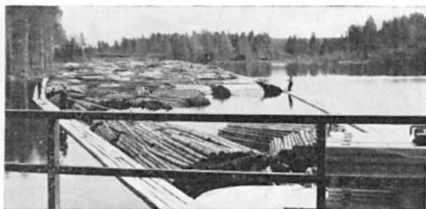
Kuva 11. Nippujen kuljettaminen syöttökanavaan käynnissä Puntarikoskella. Verraten etäällä kanavan suusta virta painaa nippuja oikeanpuoleista puomia vasten. Sen sijaan lähellä kanavan suuta (sillan alla) virtaus on niin vähäistä, ettei siitä ole haittaa, mutta ei myöskään hyötyä nippujen kuljetukselle.
