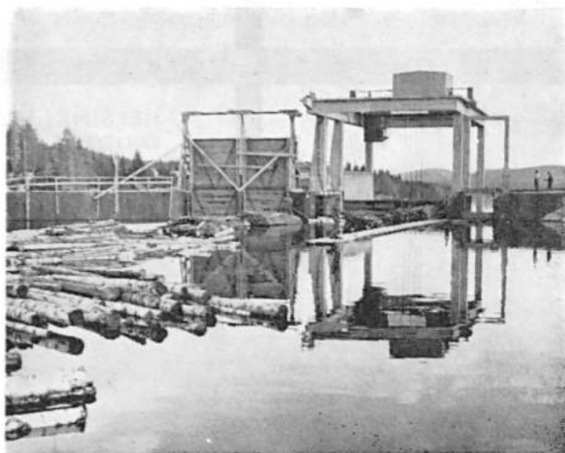
Kuva 2. Atron nipunosturi yläaltaan puolelta nähtynä. Fig. 2. Atron's bundle lift seen from the upper basin.
