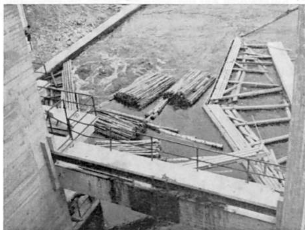
Kuva 6. Atron ala-allas oli varustettu kahdella syväpuomilla sekä pintavirran kehittäjällä. Näistä huolimatta tuotti vaikeuksia saada niput kulkemaan voimalaitoksen imuaukon aiheuttaman vastavirta-alueen poikki. Fig. 6. Atron's lower basin has two wall booms and a surface current generator. Despite this it proved difficult to get the bundles across the countercurrent area produced by the suction aperture of the power plant.
