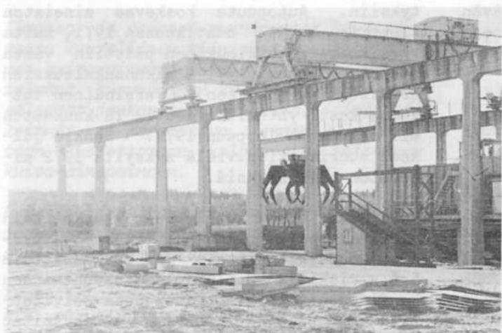
Kuva 2. Yleiskuva siltanosturialueesta. Etualalla olevan kopin luona otettiin näytetaakoista jyrsimellä purunäytteet kuiva- ainepitoisuuden selvittämiseksi. Taustalla siltanosturi upotusmittauslaitteineen
